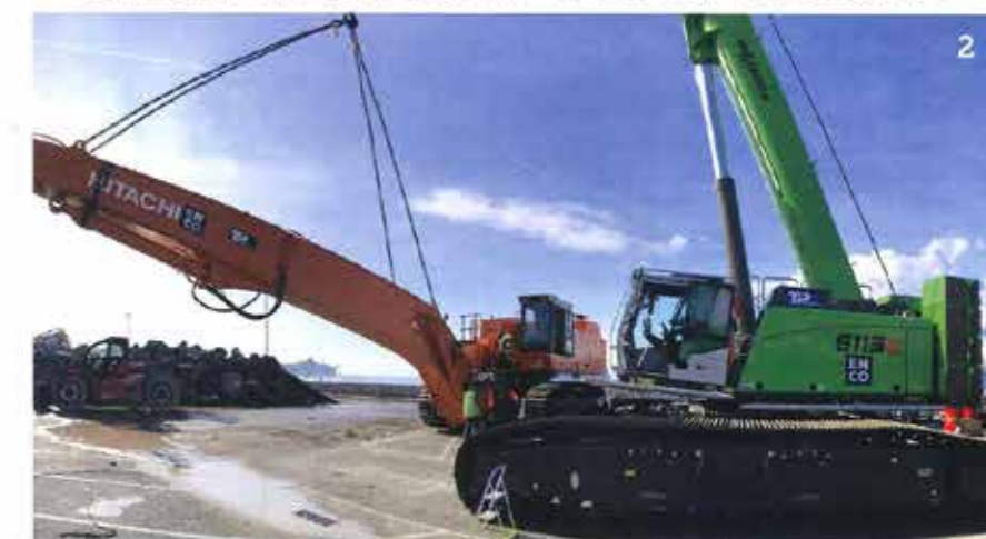
2. CANNES. UNE GRUE TÉLESCOPIQUE EN CONSOLIDATION DE DIGUE
